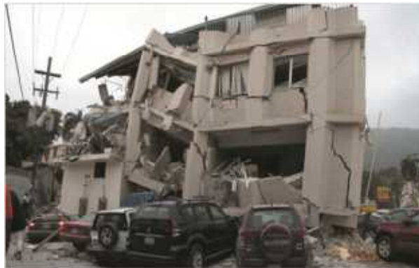
Efectos de un terremoto. Haití
