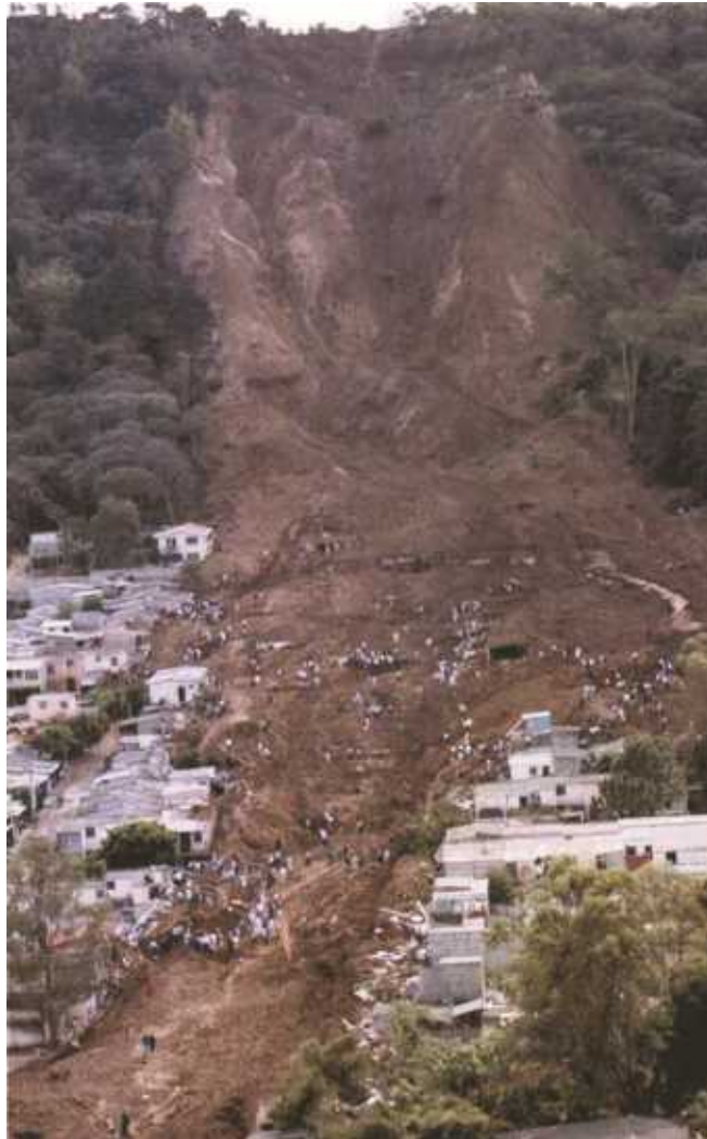
Deslizamiento. Colonia Las Colinas, El Salvador
