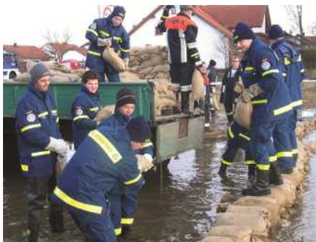
Efectivos de emergencias construyendo una barrera de sacos de arena. Pfaffenhofen, Baviera, Alemania
