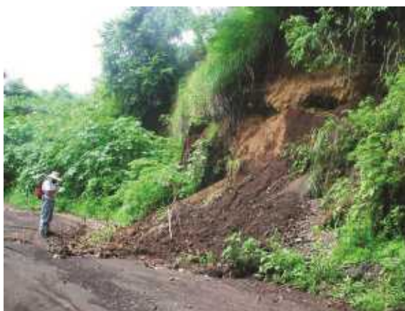
Estudio de taludes en El Salvador
