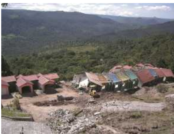
Deslizamiento en la carretera a Danlí. Honduras
