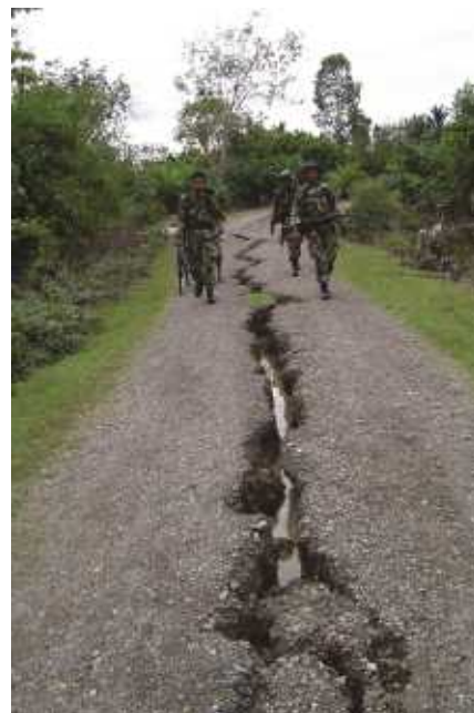
Grieta producida por un terremoto. Sumatra
