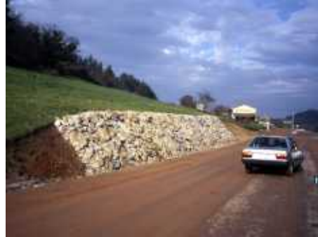
Muro de contención. Candás, Asturias
