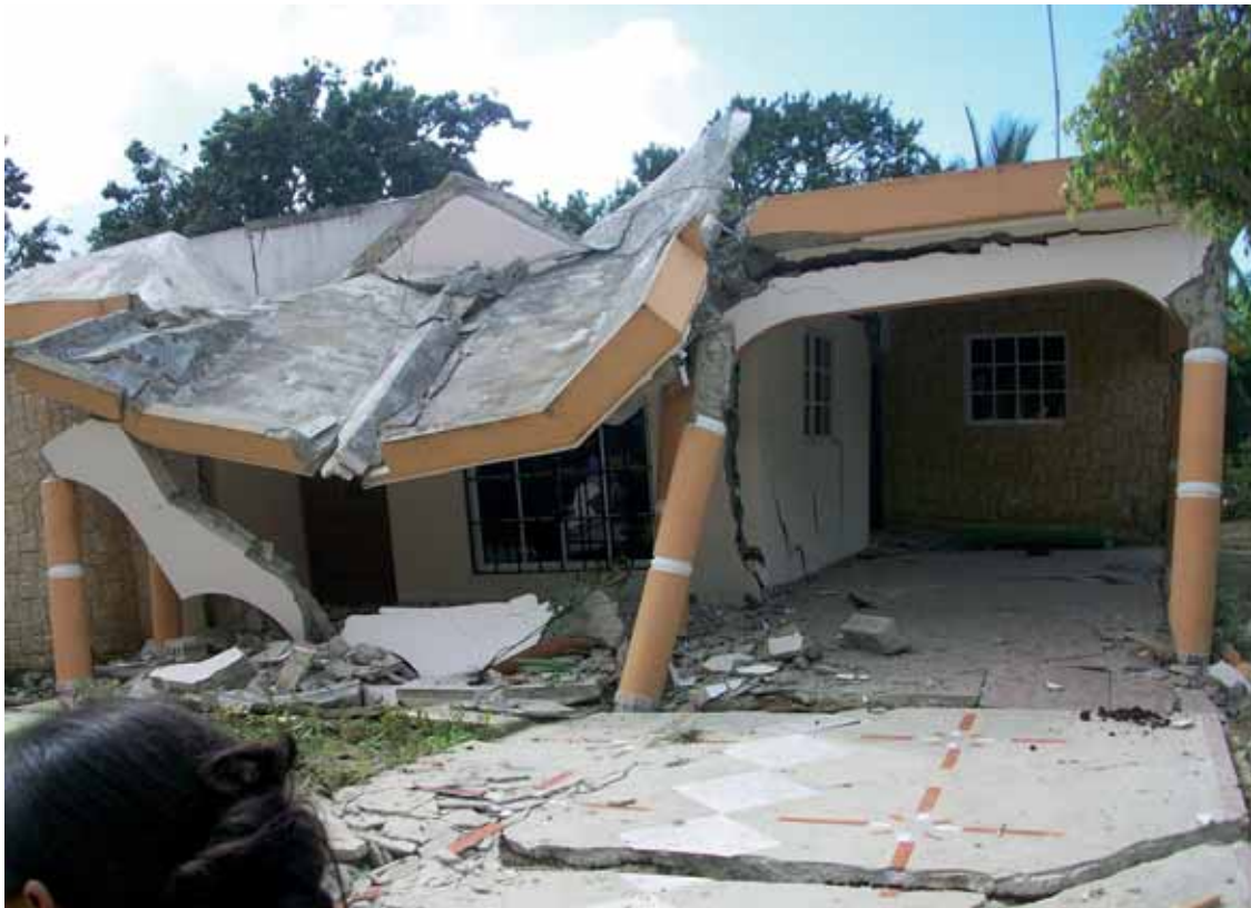
Figura 11. Daños en viviendas por movimientos del terreno. Deslizamiento en Carlos Díaz, región de Tamboril, República Dominicana, febrero de 2009 (foto cedida por Santiago Muñoz, SGN, República Dominicana).
