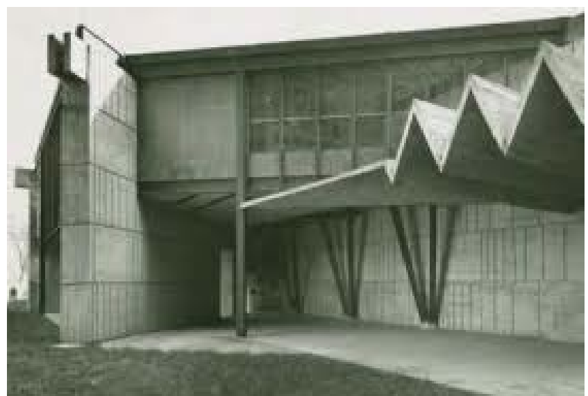
Aspecto original de la zona de acceso al edificio departamental
