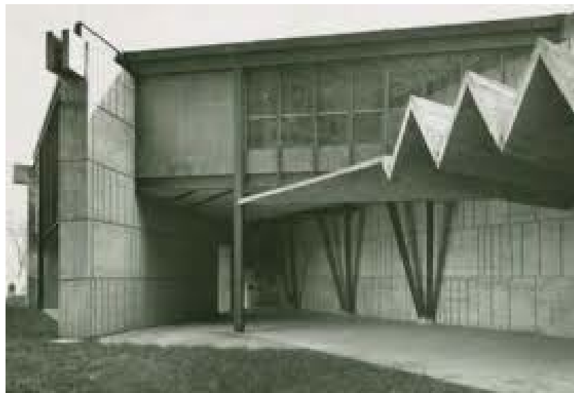
Aspecto orixinal da zona de acceso ao edificio departamental
